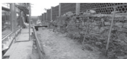
Terénní úpravy pozemku mezi přístavbou ekocentra a obvodovou zdí.
