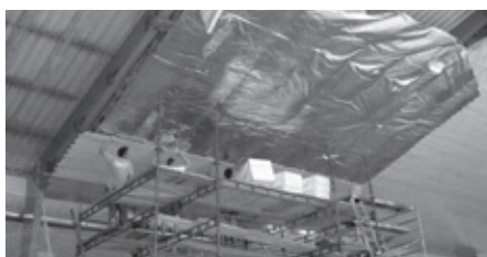
Zateplování stropu školní sportovní haly.
