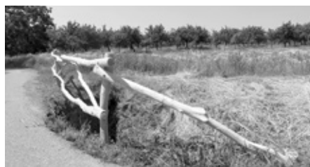
Opravený most na „zkratce“ do Bořetic.
