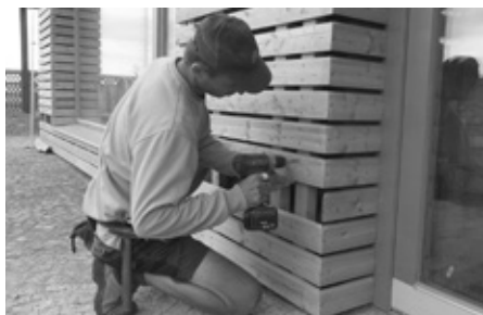
Instalace dřevěného obložení budovy přístavby ekocentra.
